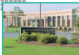
トロント(カナダ)プラント1&2
